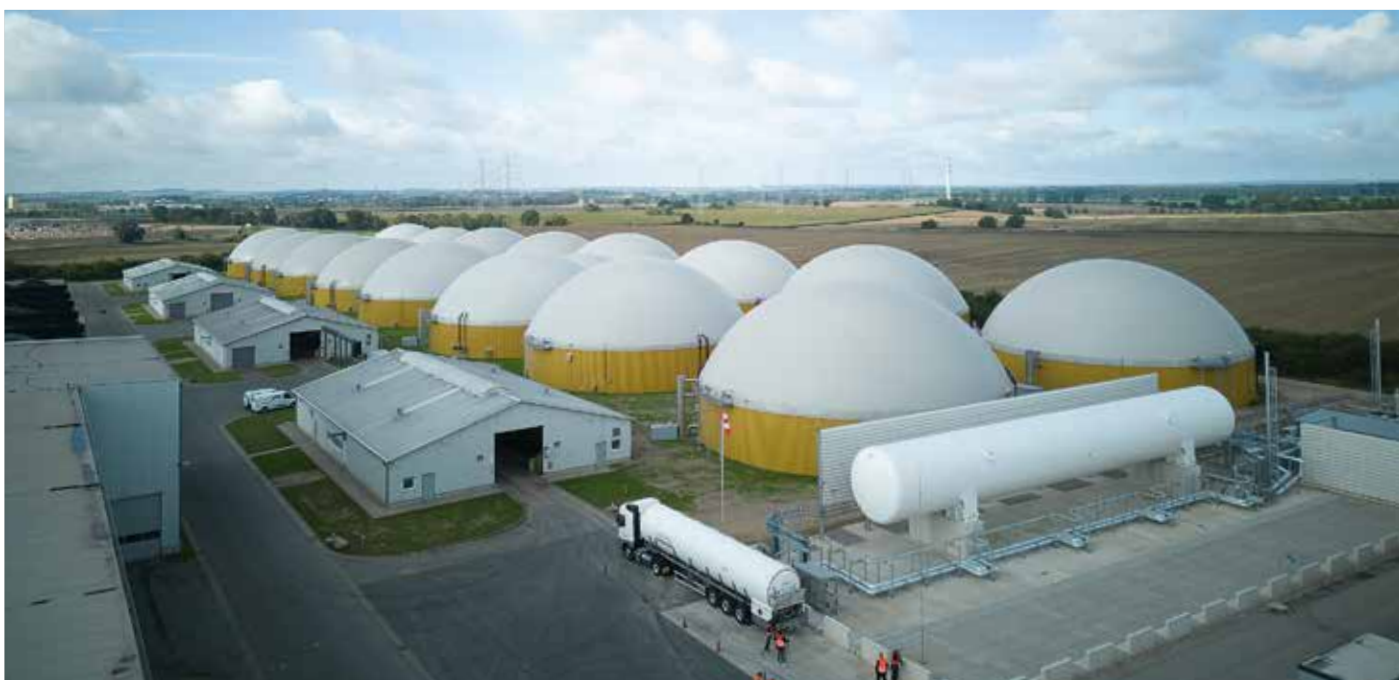
Der Bioenergie Park Güstrow ist Deutschlands größte integrierte Bio-LNG-Anlage.
