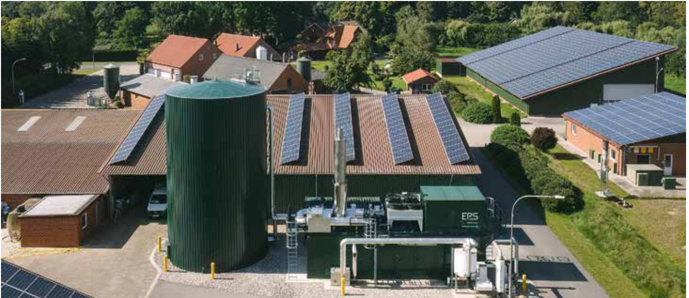
Speicherkraftwerk, bestehend aus Pufferspeicher (links) und Blockheizkraftwerk (rechts).
