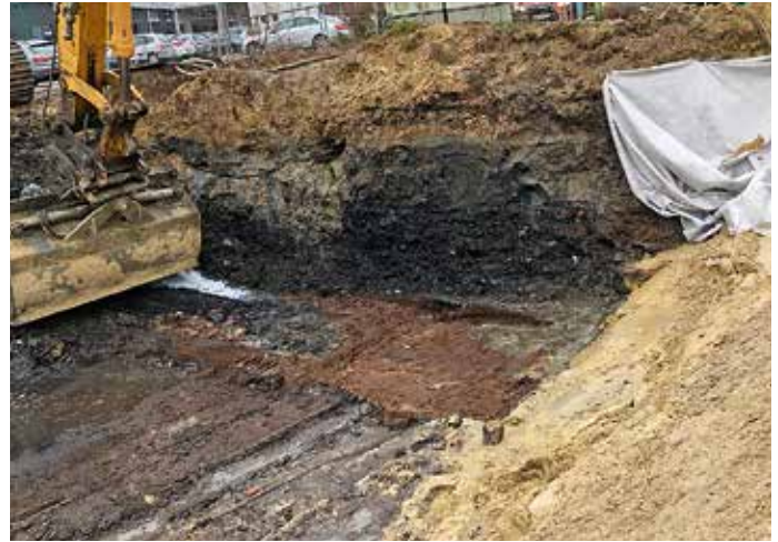
Erdbauliche Sanierung einer Altablagerung.
