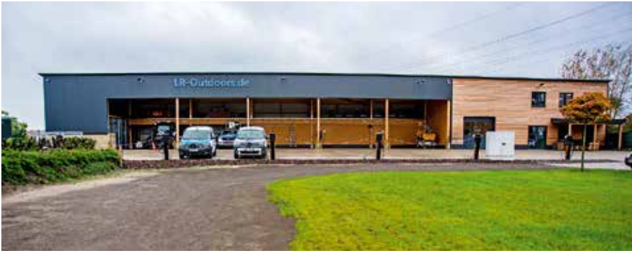
Ökologisch wertvoll: Das neue Servicegebäude wurde in klimaschonender Holzbauweise erstellt. Elektroladestellen, eine Photovoltaikanlage sowie eine Heizung mit Geothermie runden den umweltfreundlichen Komplex ab.
