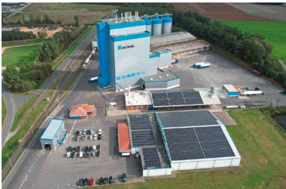
Das 2016 modernisierte Werk in Löningen mit Gleisanschluss.
