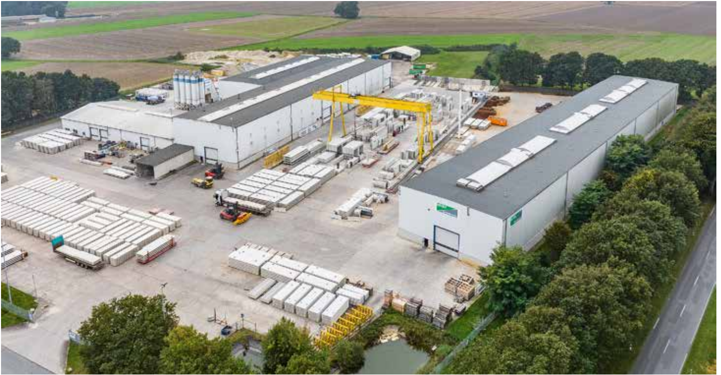
Die Carbonbeton-Innovation aus Essen wird im ehemaligen Betonwerk Greten hergestellt.
