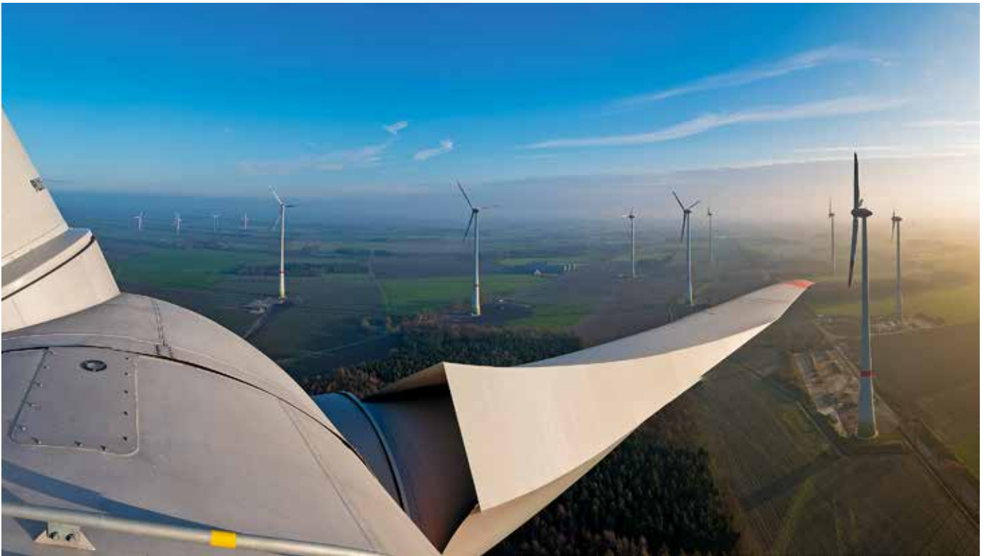
Ein Blick aus der Höhe auf den Bürger-Energiepark Garrel: Nachhaltige Energieerzeugung durch moderne Windkraftanlagen.
