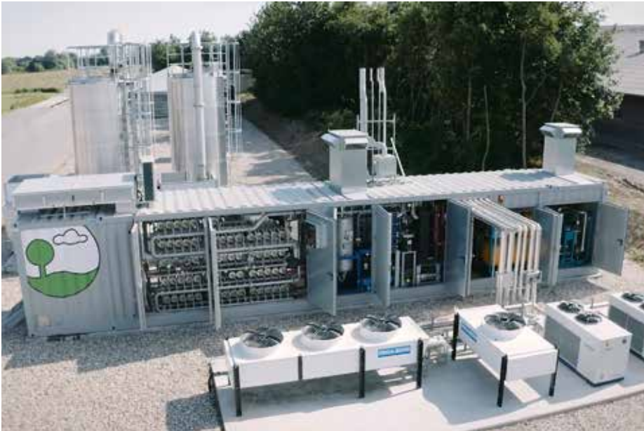
Die EnviThan-Gasaufbereitungsanlagen bereiten Rohbiogas zu hochreinem Biomethan auf, das direkt ins Erdgasnetz eingespeist oder zu Bio-LNG verflüssigt werden kann.
