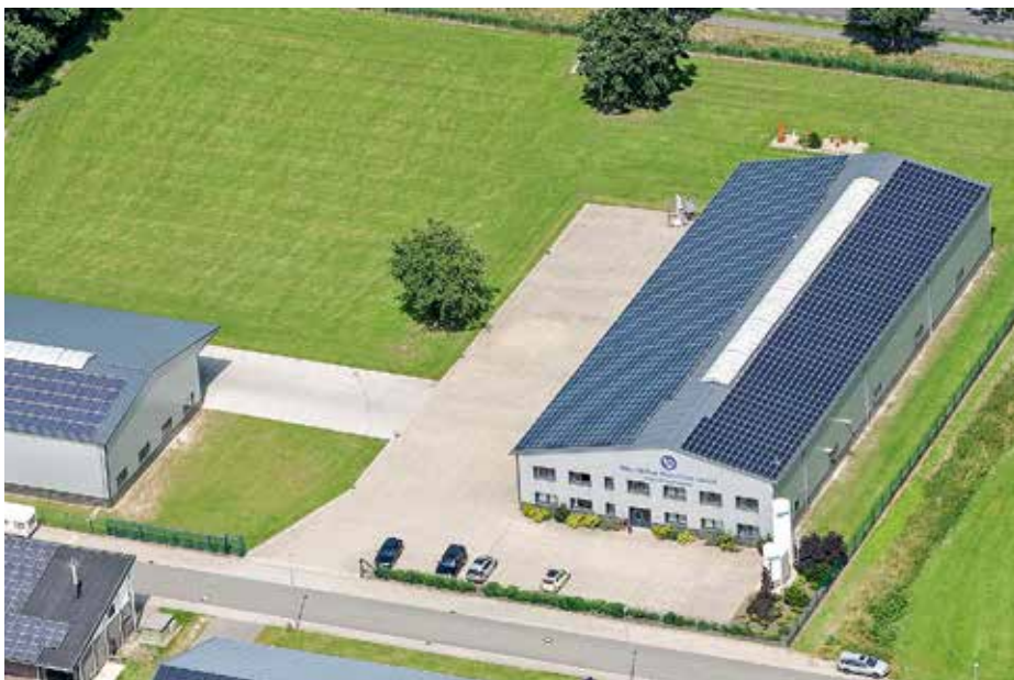
Bild oben: CAD-Station in der Baugruppenfertigung, unten Luftbild des neuen Betriebsgeländes in Friesoythe an der Werner-von-Siemens-Str. 5.
