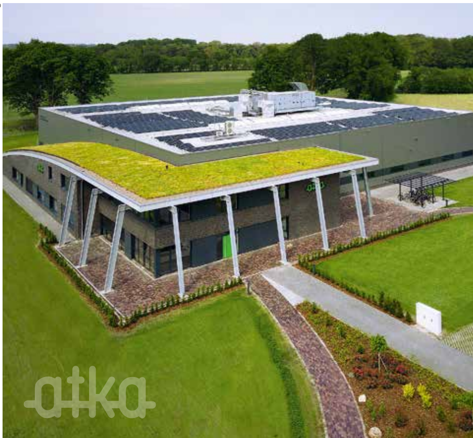
Mit dem eigenen TopGreen-Gründach fällt der neue Standort gegenüber der Hauptniederlassung sofort ins Auge.
