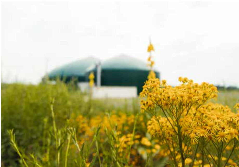
Hofkraftwerk mit einer Leistung von 150 kWel, bestehend aus Fermenter und Gärrestlager.
