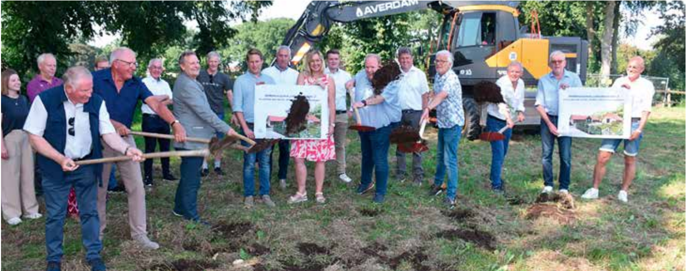
Symbolischer erster Spatenstich zur Umsetzung der Hofstelle Münzebrück in den künftigen Bürgerpark. Hier sollen zu Weihnachten dieses Jahres Tür und Tor des neuen Heimat-, Kultur- und Vereinshauses für Einheimische und Besucher geöffnet werden.
