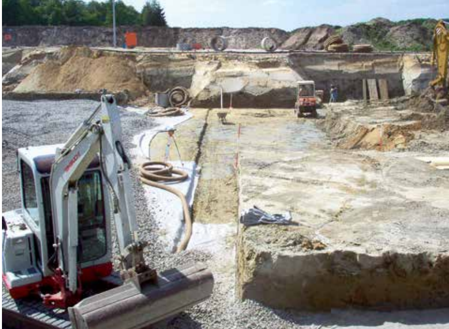
Vom Fachgutachter abgenommene Gründungssohle.
